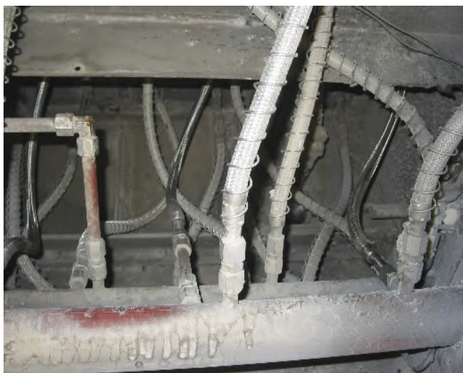
Tuyaux métalliques flexibles utilisés dans une installation d'incinération
